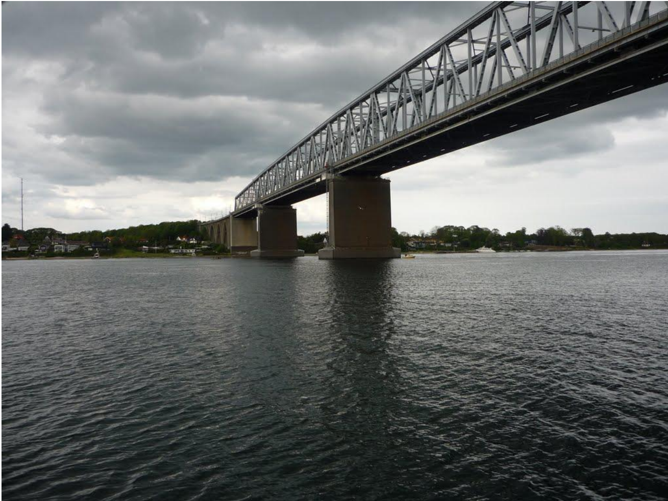
Foto 2 (G) Broens vestside set fra Fynssiden. Fotoet viser den asymmetriske konstruktion med arbejdsselevatorene på hver af bropillerne og varmetransmissionsledningen ophængt.
