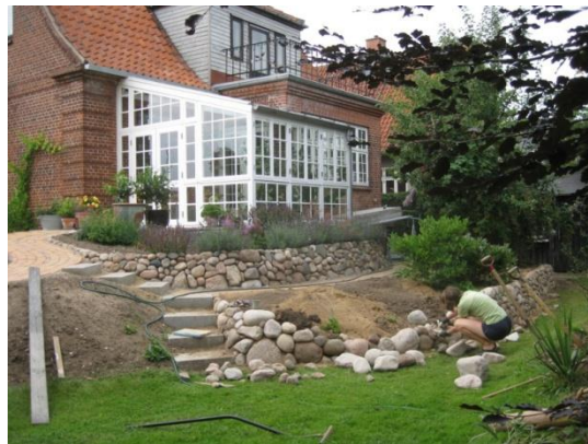
Foto 6 Renovering som udført 2011.
